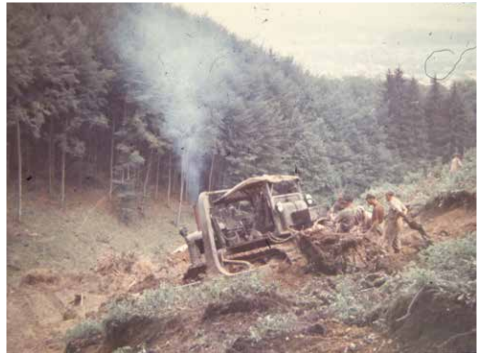
Straßenbau durch den Pramwald
