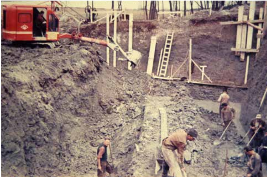
Baugrube beim Straßenbau
